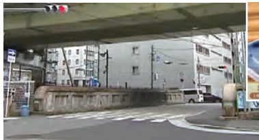
現在の出入橋
