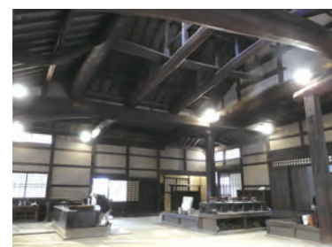
鴻池新田会所内部(国史跡・重要文化財)
