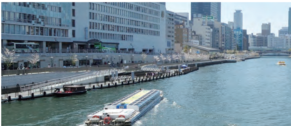
八軒家浜棧橋と遊歩道
