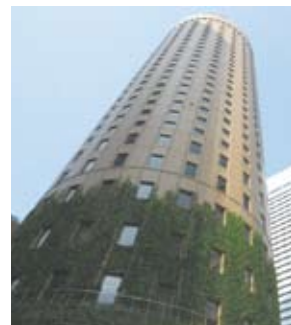
大阪マルビル緑化プロジェクト(2013年6月/大阪市北区)
