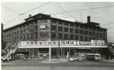
大和駅前交通安全陸橋(1963年/大和駅前)
