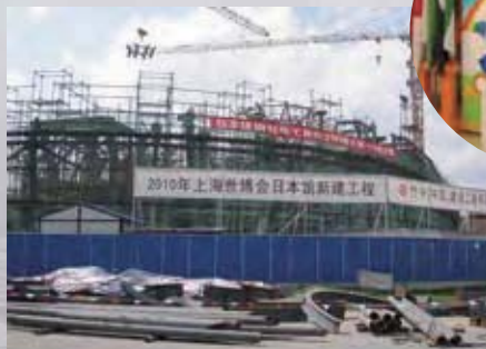
骨組み工事中の日本館
