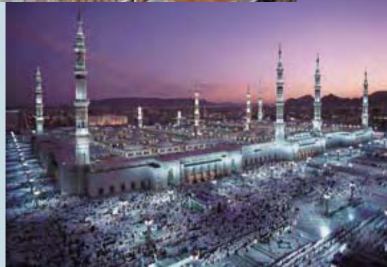
大型アンブレラが設置される聖地メディーナの広場(2010年完成予定)
