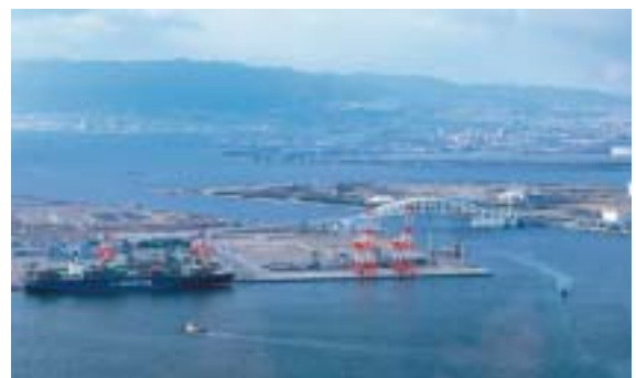
夢洲では海外物流企業のコンテナヤードの建設が進む
